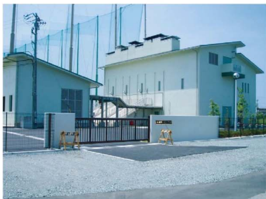
馬瀬第1ポンプ場
